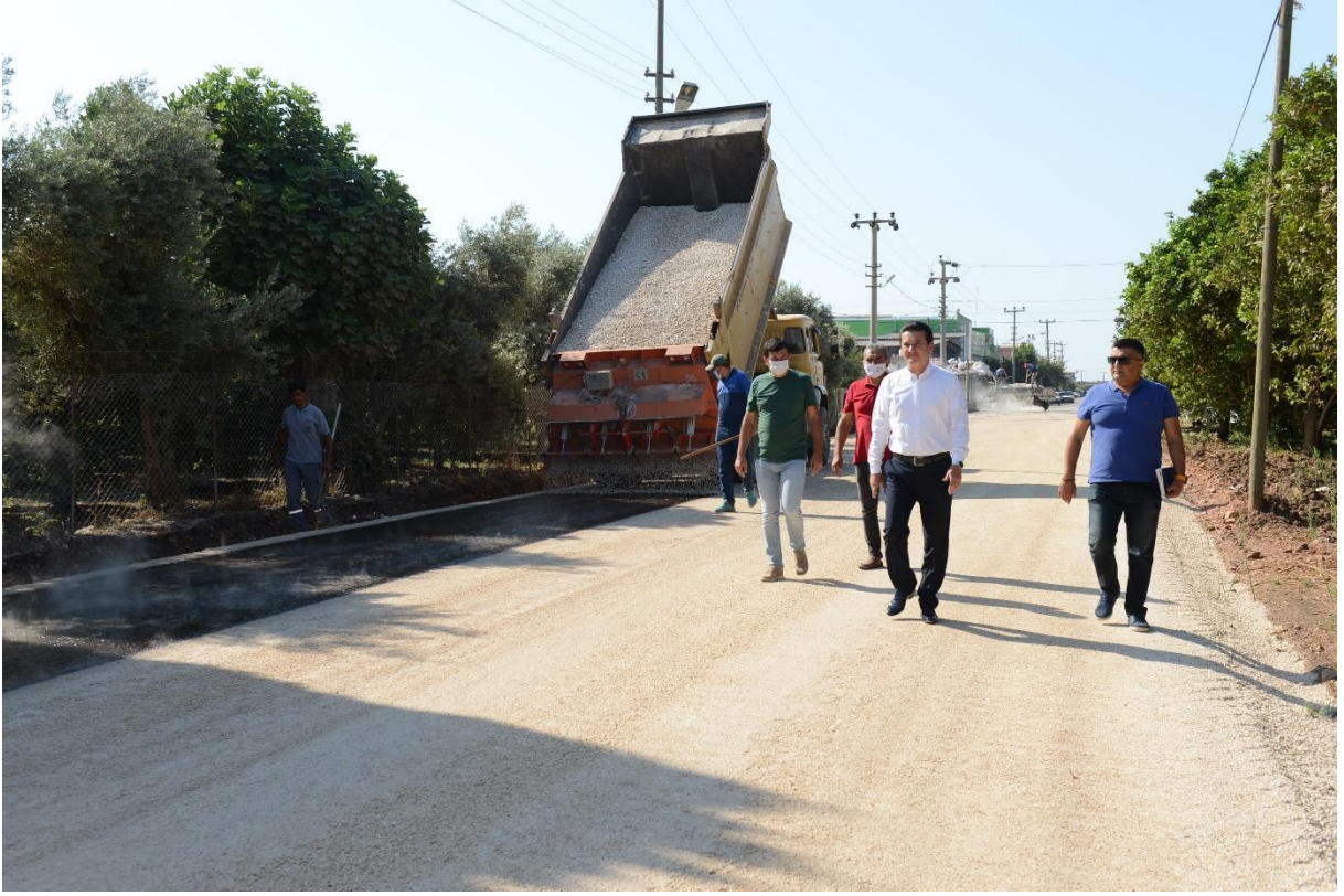
Merkez ve Kırsal alandaki asfaltlama çalışmalarımız
